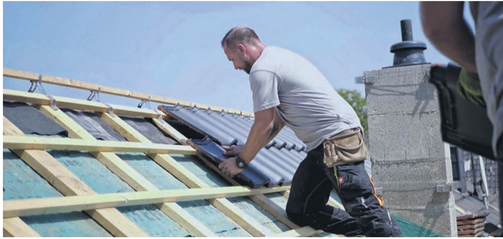
Ob Zimmermann, Dachdecker oder Spengler: Fachhandwerker sind für die Planung einer Dachsanierung unverzichtbar.
