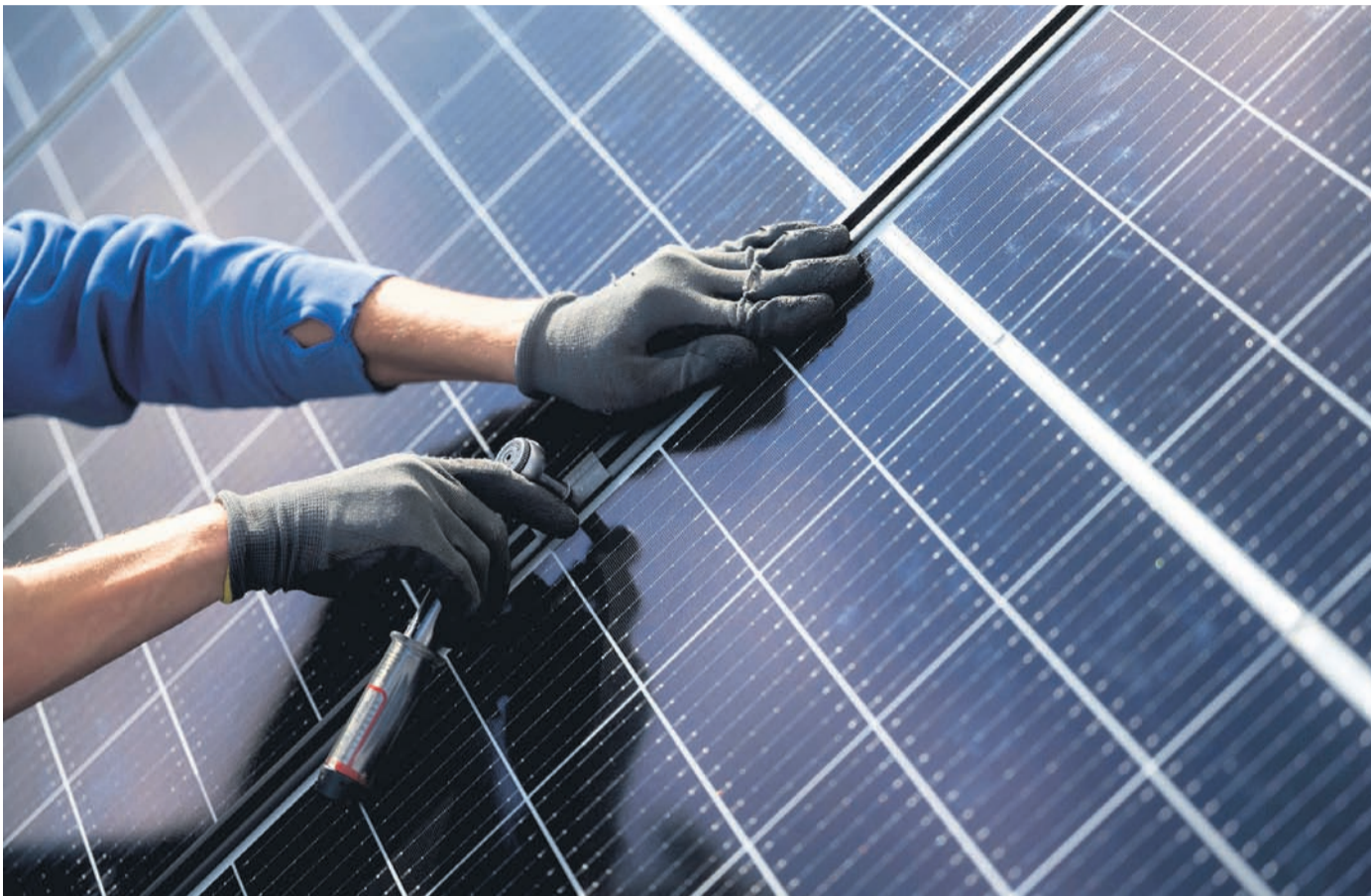
Photovoltaikanlagen sind von deutschen Dächern kaum mehr wegzudenken. Einnahmen aus dem Verkauf von Solarstrom können von der Einkommensteuer befreit sein. FOTO: MARIJAN MURAT/DPA
