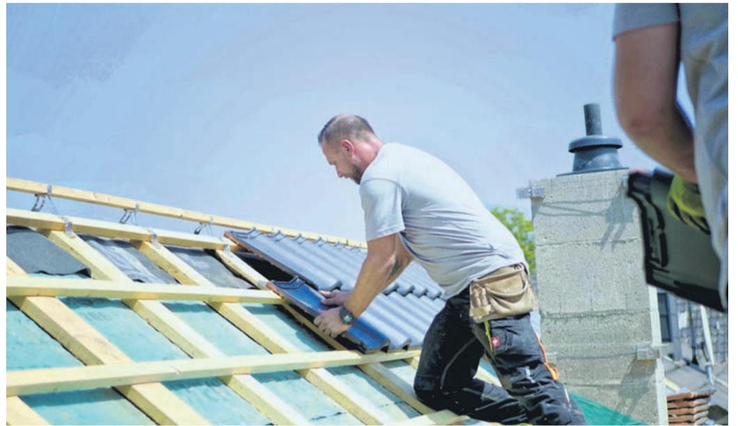
Ob Zimmermann, Dachdecker oder Spengler – Fachhandwerker sind für die Planung einer Dachsanierung unverzichtbar.
