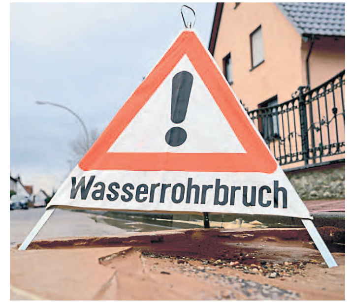
Bringt Ärger: ein Wasserrohrbruch.
