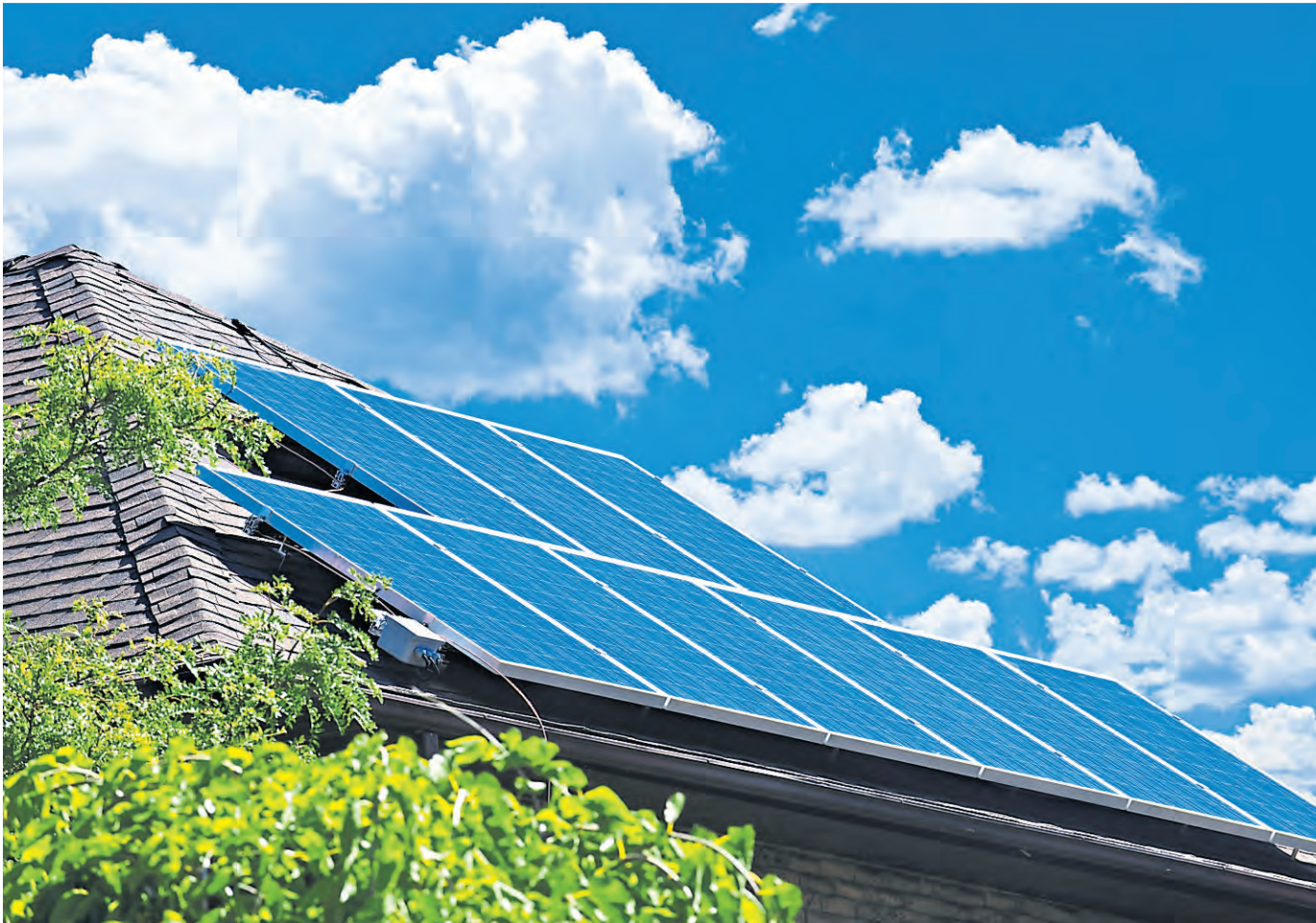
Wer eine PV-Anlage auf dem Hausdach installieren möchte, sollte frühzeitig die baulichen Voraussetzungen, Fördermöglichkeiten und Finanzierungsbedingungen prüfen. Foto: VZ NRW/adpic
